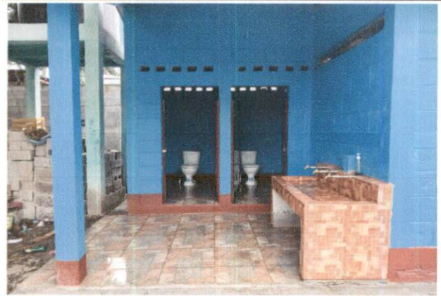
Foto 2: Instalación de dos Sanitarios y piso cerámico antideslizante.
