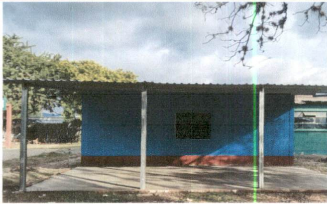
Foto 1: Reparación de cocina y construcción con su galera.
